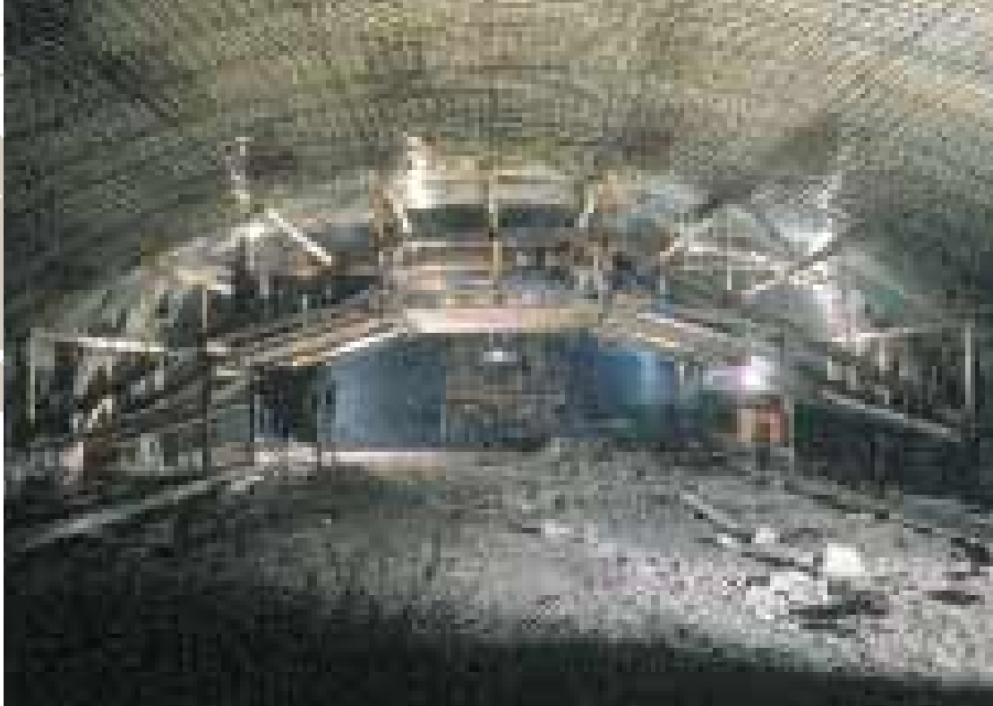
Formsättning av fribärande sprutbetongvalv.
