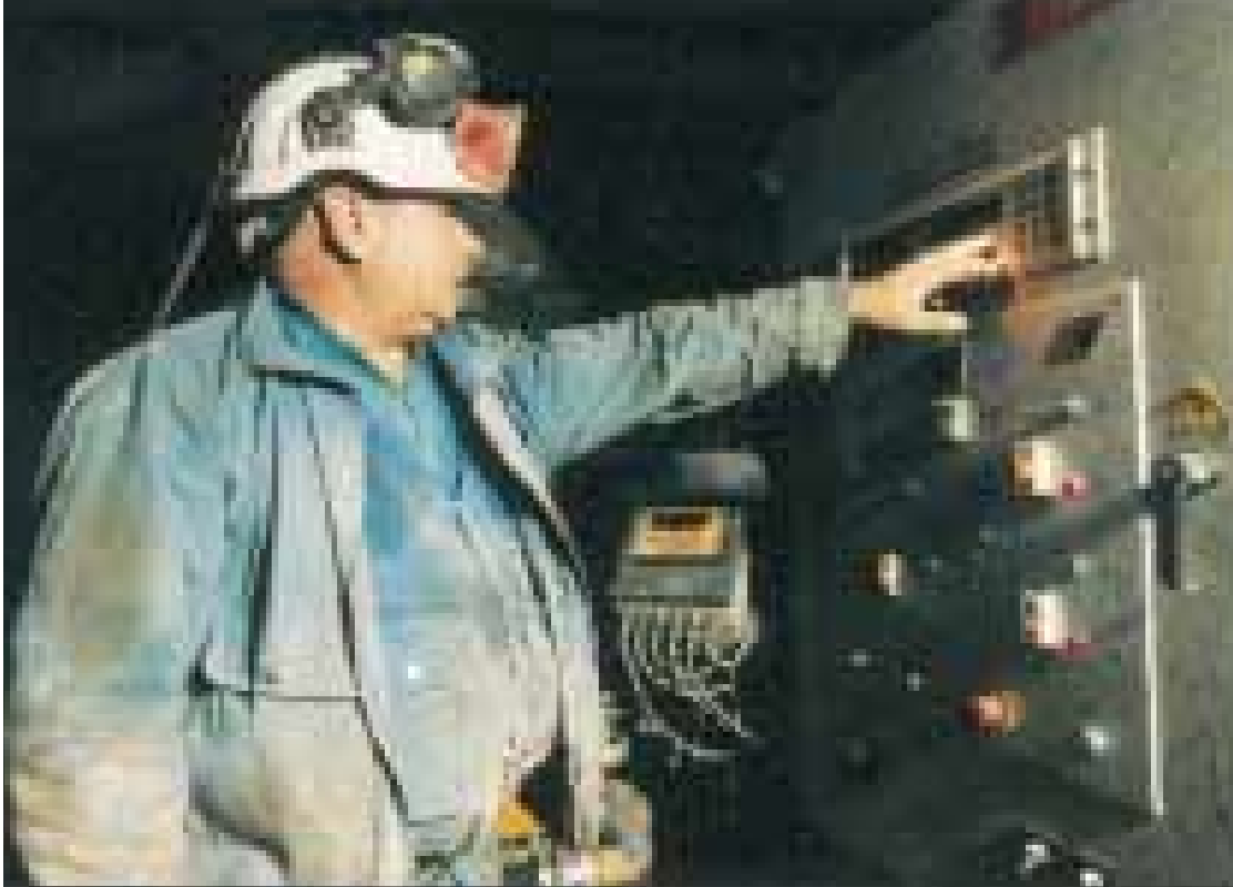
Datorstyrd injekteringsutrustning vid Arlandabanan.
